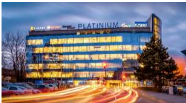
Administrativní budova Platinum, Brno, ČR
