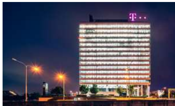
Administrativní budova Forum BC I, Bratislava, SR
